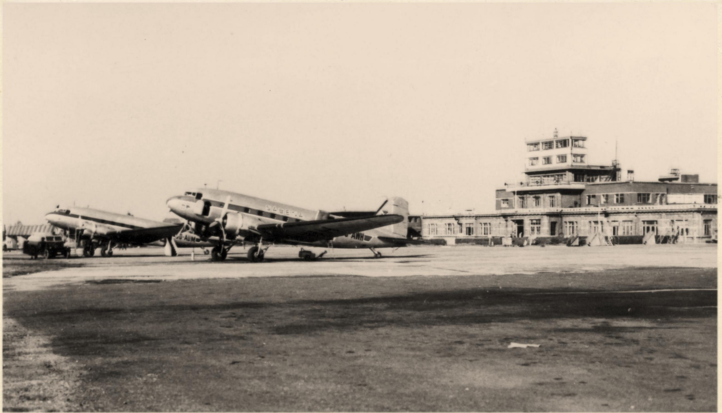
1946 - Aérogare et zone d'embarquement en béton de HAREN-EVERE
